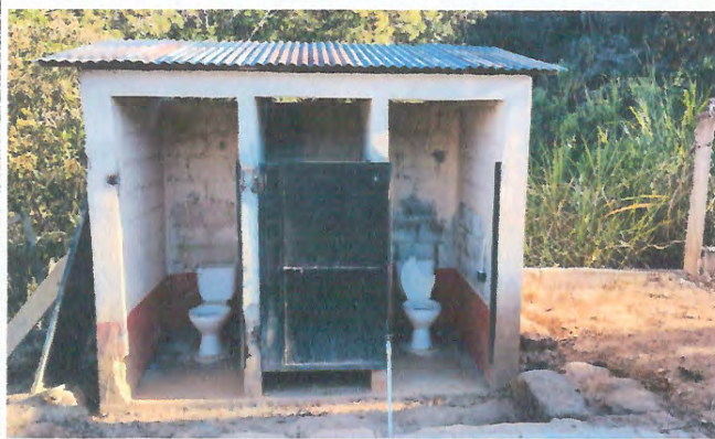
Foto 1: Mejoramiento general de servicios sanitarios y accesorios
