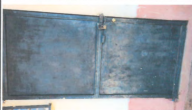
Foto 2: Mejoramiento de puertas del Establecimiento y de Cocina
